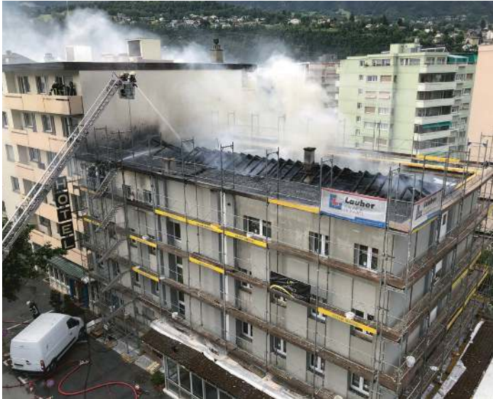
Brandbekämpfung von oben mit der ADL, welche auf der Vorderseite des Gebäudes platziert ist. Der nachalarmierte Hubretter der Stützpunktfeuerwehr Brig wird auf die Gebäuderückseite platziert.
